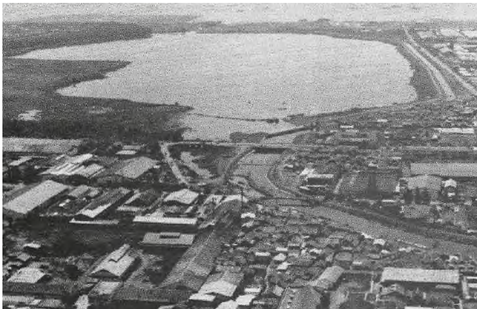
Figuur 2. Luchtfoto van het bergingsreservoir en de waterbouwkundige voorzieningen in de Pluitpolder (Kop et al., 1983)
